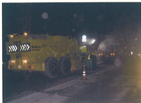
一次切削状況
