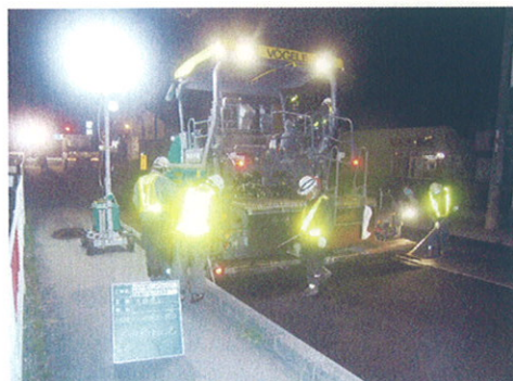
大粒径混合物舗設状況
