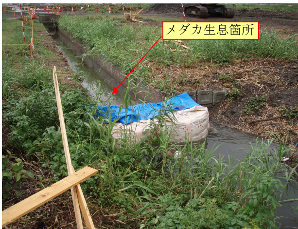
堤体に邪魔になる為に、撤去する農業用水路、いわゆるメダカ学校が3班ほど確認。
