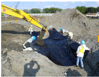
① 遮水シートを敷く
