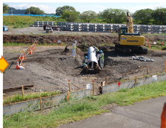
② コルゲートパイプ設置
