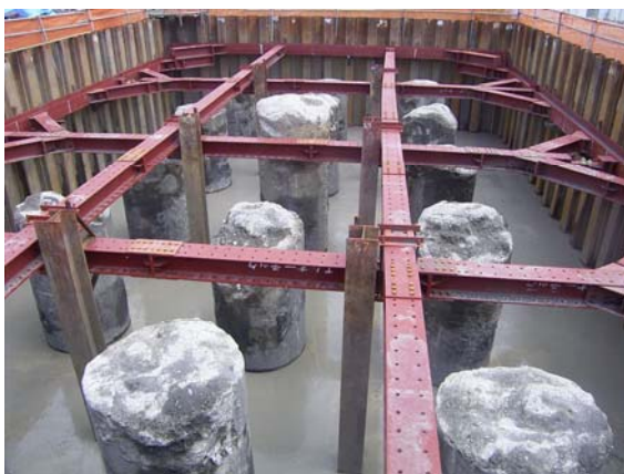
土留工完了時
