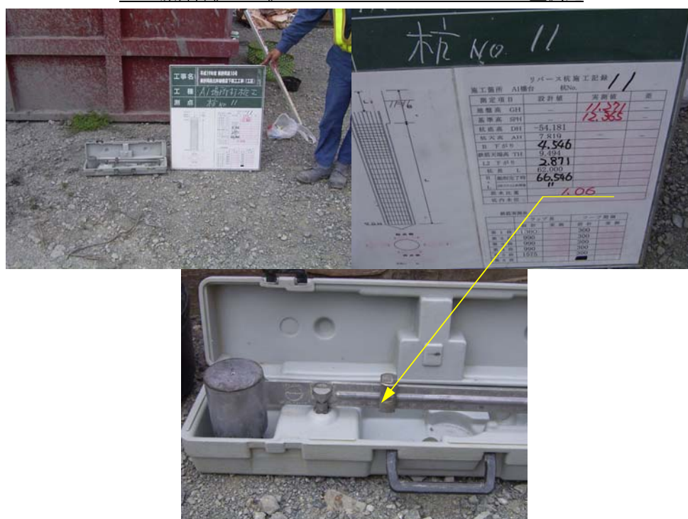
A1場所打杭工 杭NO.11 SPH-66m比重測定
