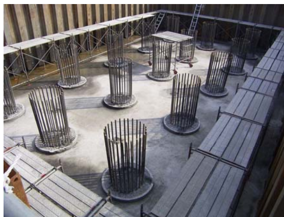
杭頭処理完了時
