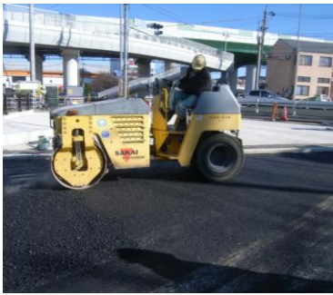
小型振動ローラー締固め状況
