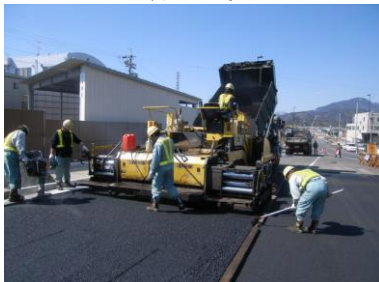
基層施工状況
