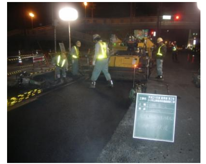
国道接続部舗設状況
