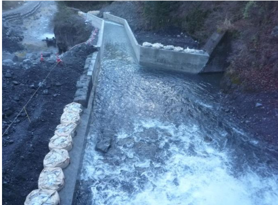
[コンクリート仮水路部]
