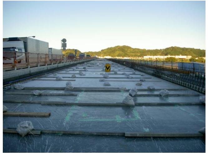
写真3 ポリフィルム敷設状況
