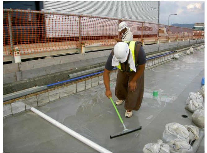
写真4 ポリフィルムの密着性向上作業
