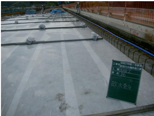
写真2 Q マット敷設状況
