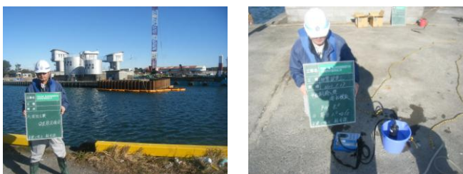
写真－6 汚濁防止膜設置状況（左）水質測定状況（右）
