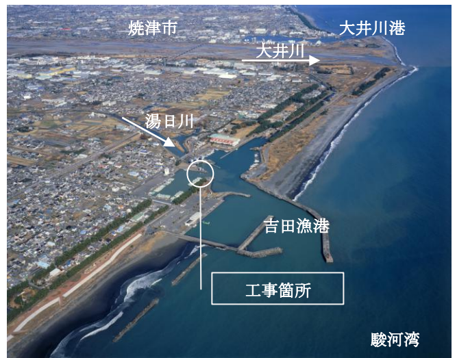
写真-1 工事位置写真
