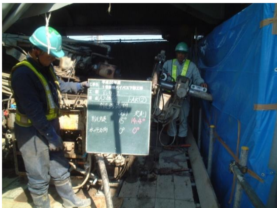
掘削作業状況
