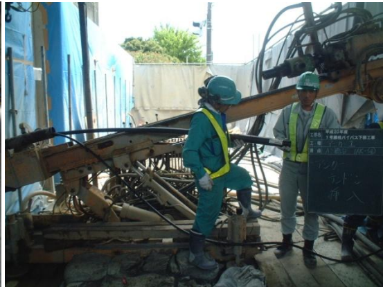
長アンカー挿入(現場管理)
