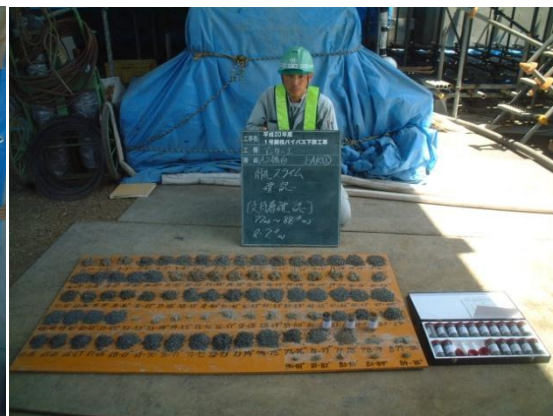
掘削土質～支持層確認状況
