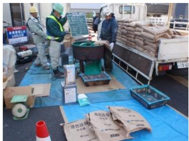
材料温度調整と混合状況
