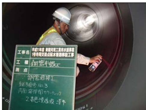
浸透探傷試験状況
