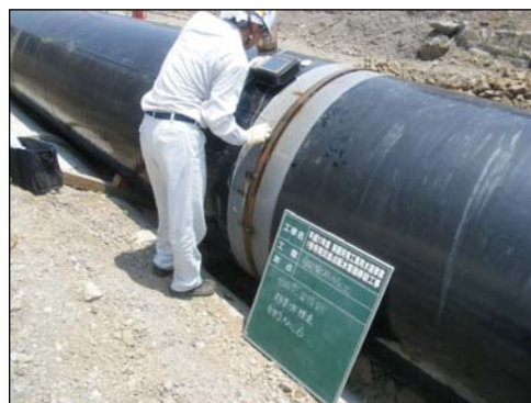
超音波探傷検査状況
