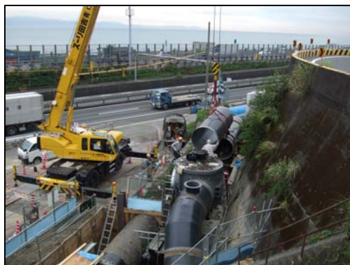
鋼管吊り込み状況
