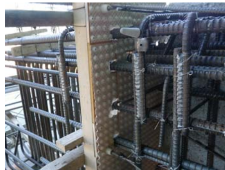
型枠取付状況
