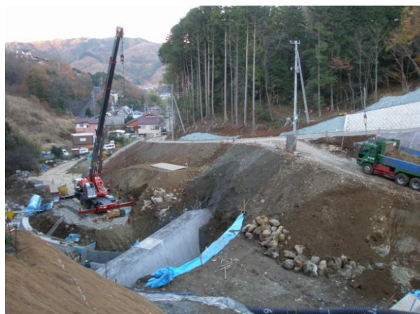
工事用搬入路 2
