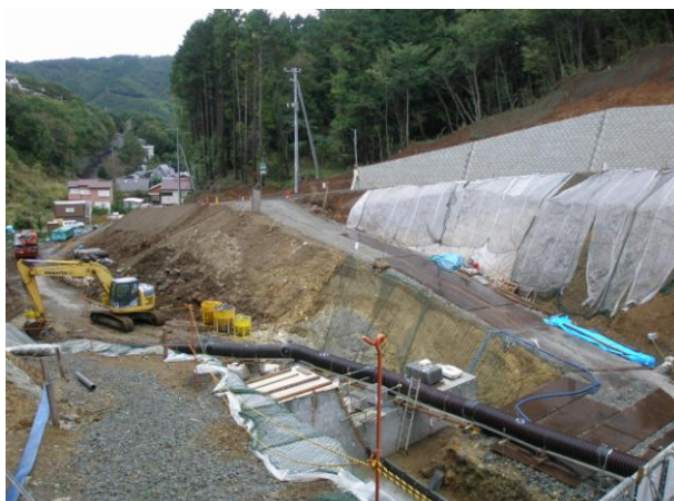
工事用搬入路 1
