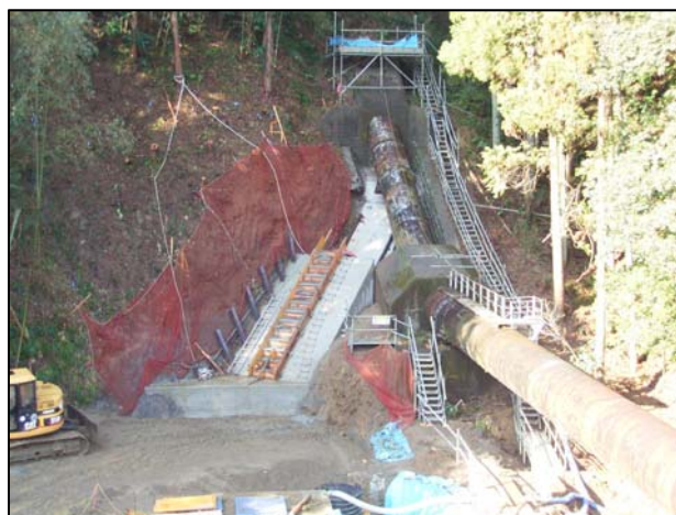
仮設養生ネット設置状況
