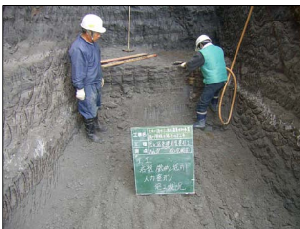
隅角部の人力切削作業
