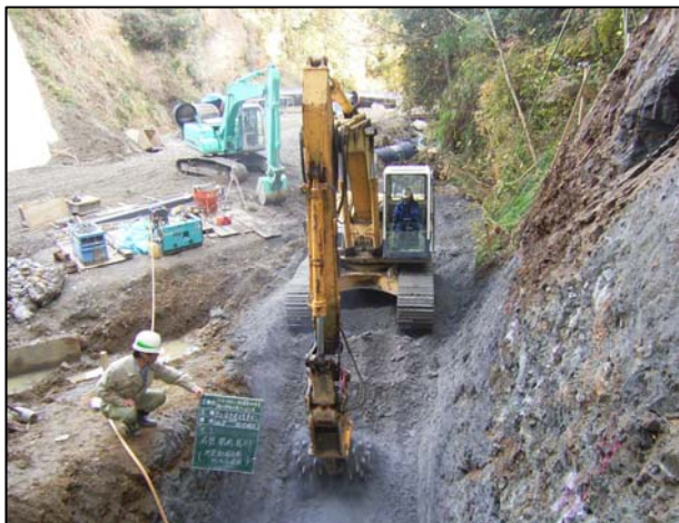
掘削作業状況
