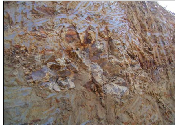
支持基盤の上に強風化泥岩、その上に粘性土（表土）
