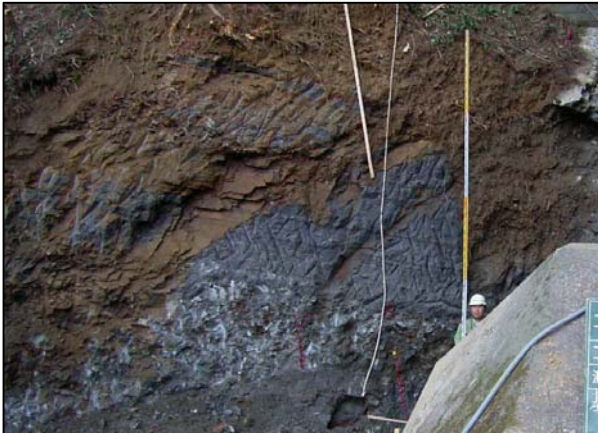
支持基盤の上に強風化泥岩、その上に粘性土（表土）
