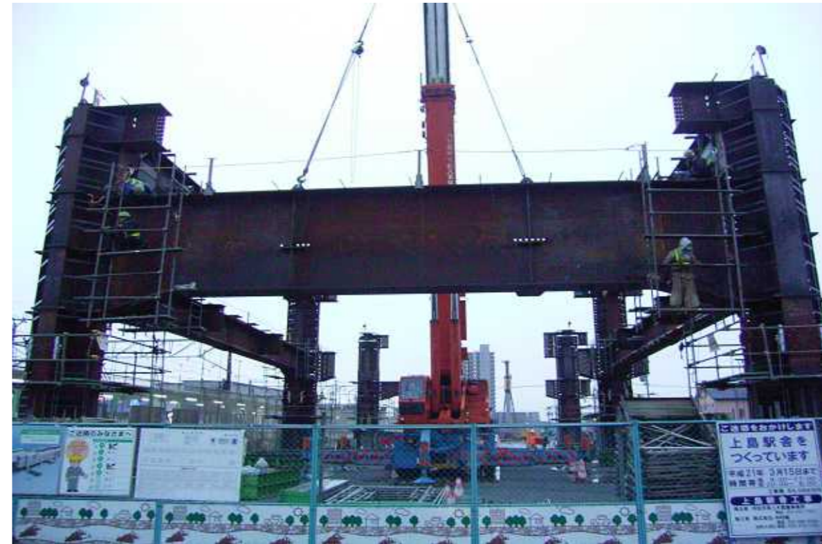
支柱部第2節・梁 (昼間)
