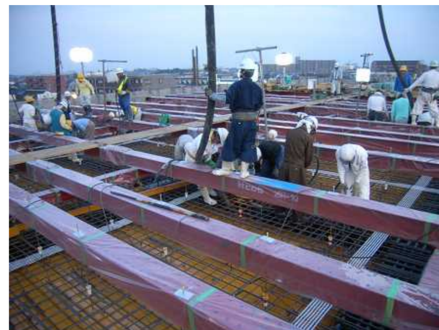
打設状況 3班施工
