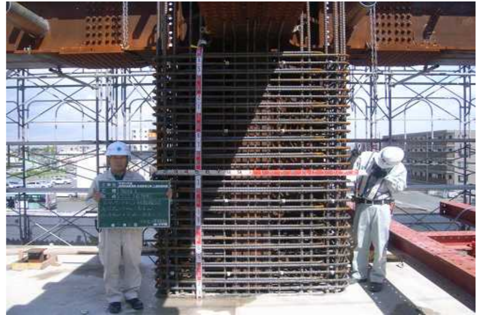
柱部鉄筋状況
