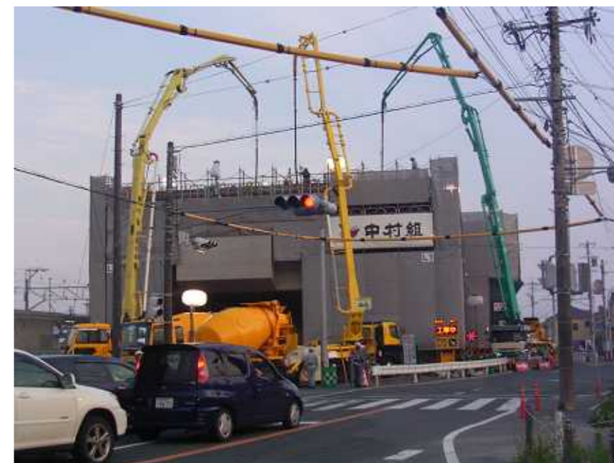
打設状況（北側軌道階）
