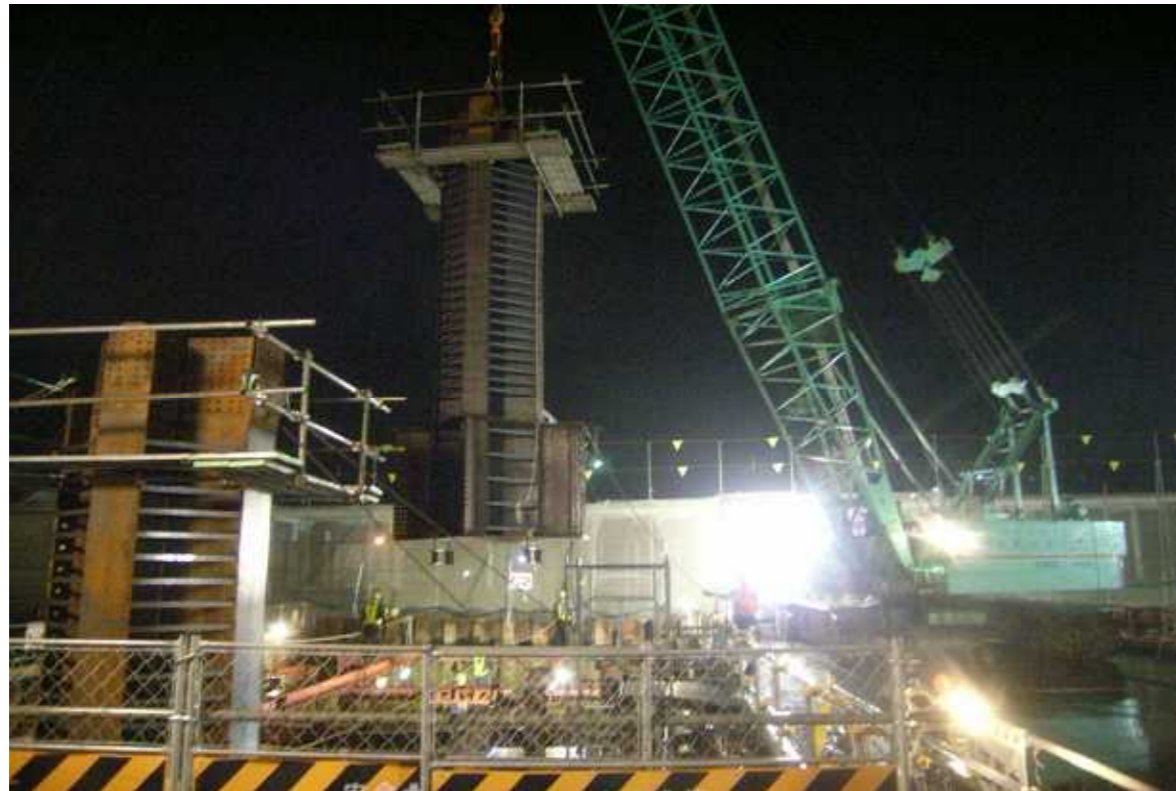
支柱部第1節 (夜間)
