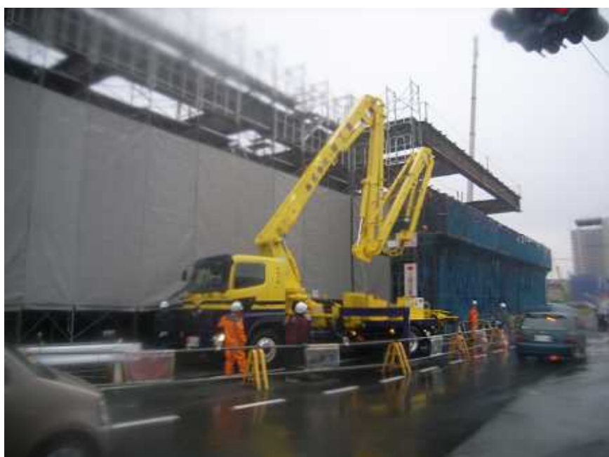
ポンプ車打設前実機テスト
