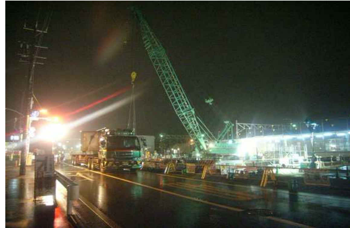
支柱荷降ろし状況
