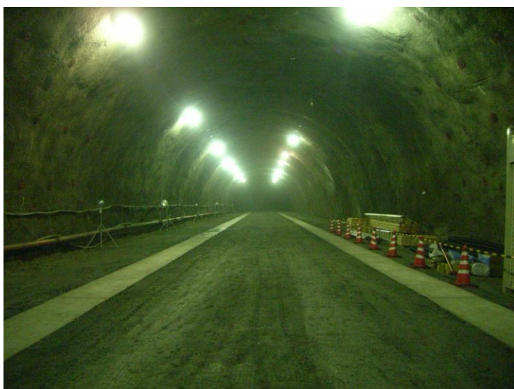
レール基礎全景
