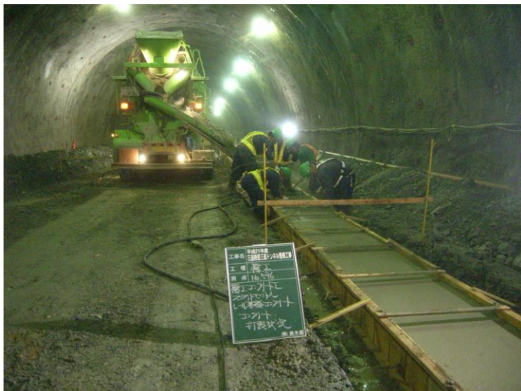
レール基礎 コンクリート打設状況
