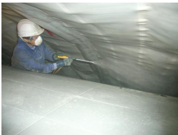
水性剥離剤塗布状況
