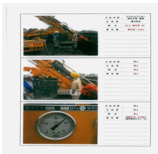
図-2 (試験削孔状況)
