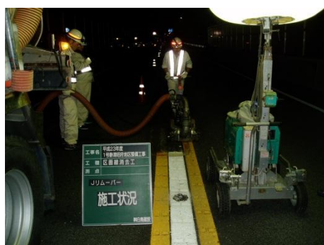
写真1 Jリムーバー施工状況
