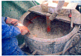
対策前攪拌機投入口
