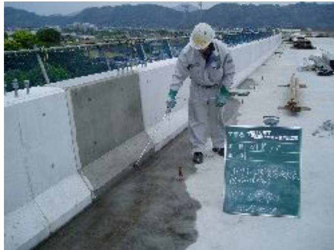
『初期乾燥ひび割れ抑止剤 ウォーターケア』散布状況
