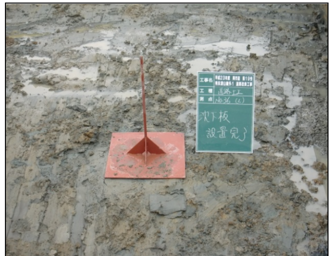
写-1 沈下板設置
