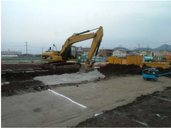
敷き均し状況
