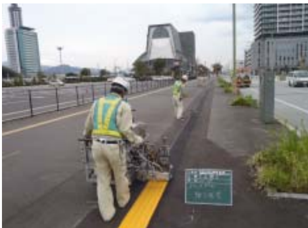
仮設誘導帯施工状況
