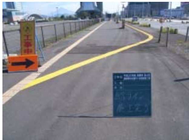
仮設誘導帯施工完了
