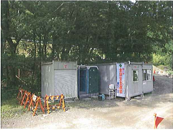
※3. 木陰に設置した現場休憩所
