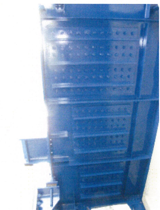
【作業完了】 上流～下流
