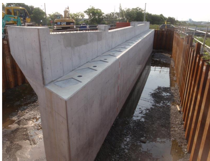
橋台躯体工：完成
