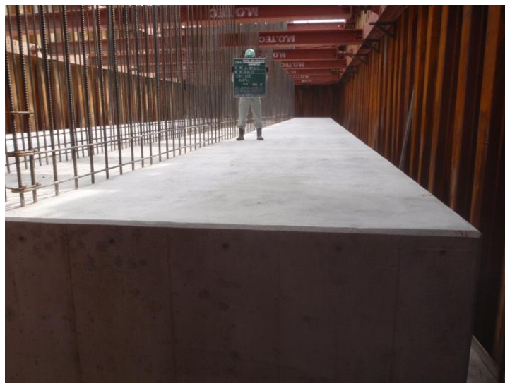
底版部完成時：豎壁部鉄筋組立状況
