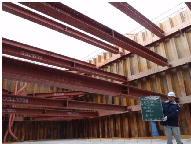
3段目切梁撤去前段階確認(発注者)
