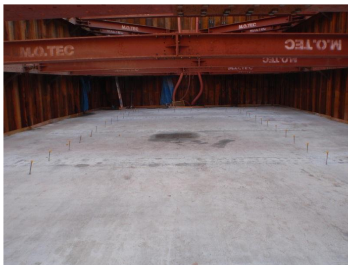
変更基礎工の完了状況：切梁撤去前
