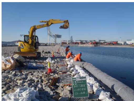
写真-1 バックホウ使用状況
