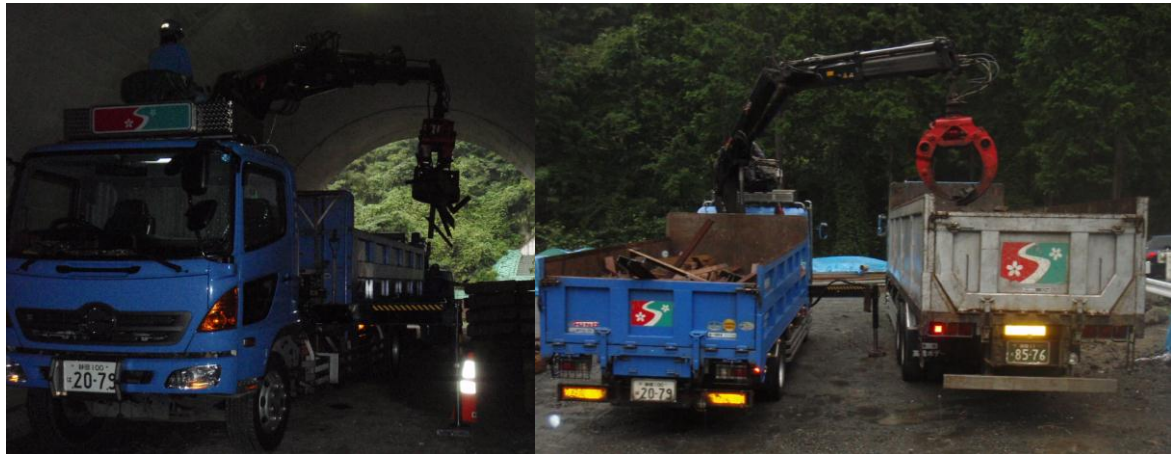
トンネル坑内の積込み写真
