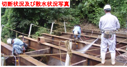
切断状況及び散水状況写真
