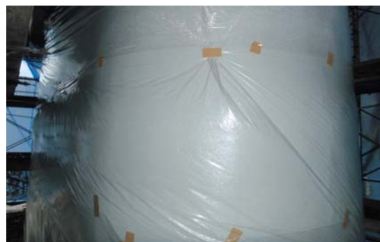
ビニールシートによる養生
