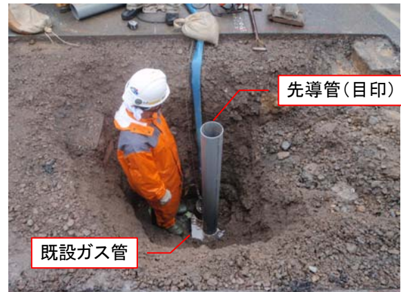
先導管（目印）設置
