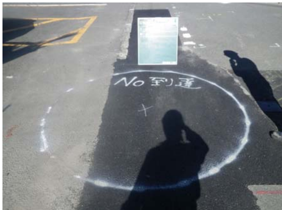
立坑築造箇所
