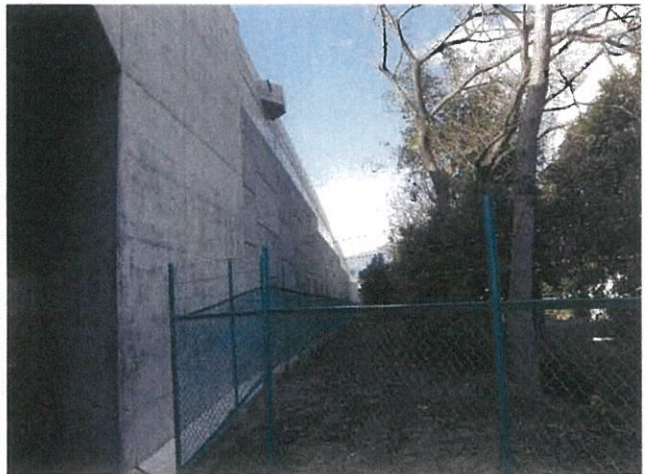
② 起点 右側 完成
