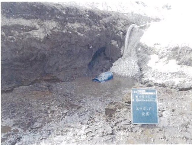
支持地盤 水中ポンプ設置状況
