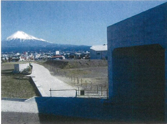
① 起点 左側 着工前
