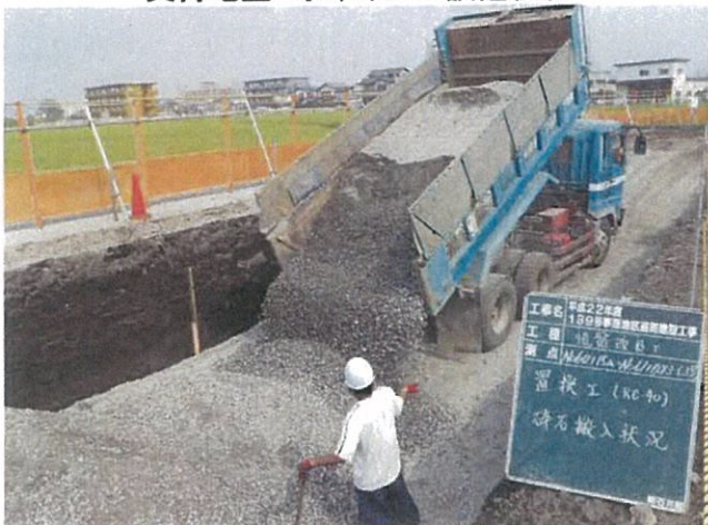
砕石置換状況
