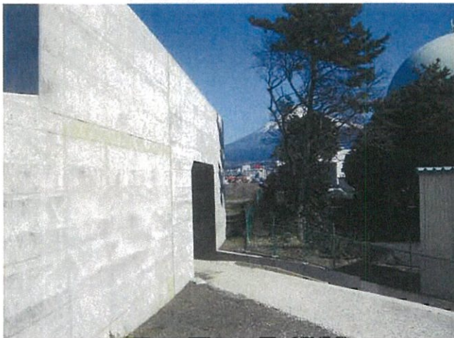
② 起点 右側 着工前
