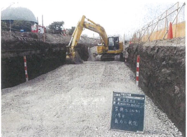
砕石敷き均し状況
