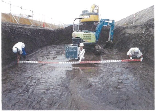
掘削完了 出来形測定
