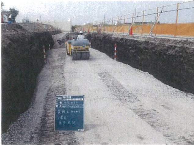
砕石転圧状況
