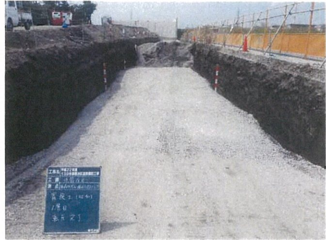
砕石置換完了
