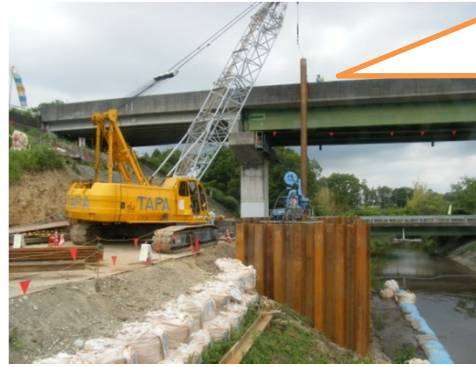
施工状況（鋼矢板打込み 圧入機）
