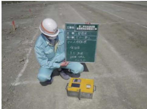
締固め度測定状況
