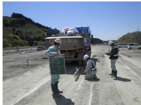
走行試験・たわみ試験実施状況
