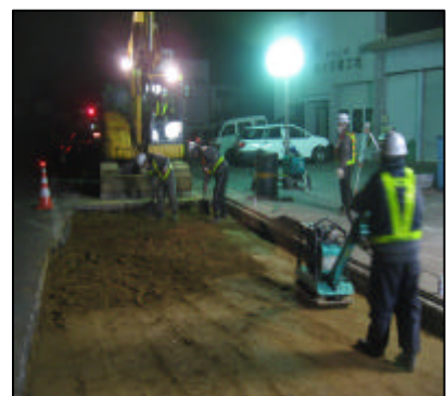
路床盛土 振動コンパクタ-併用
