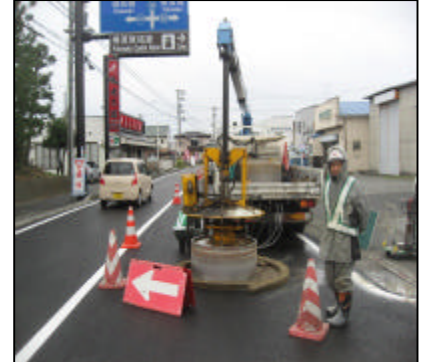
舗設完了後(2次施工)
