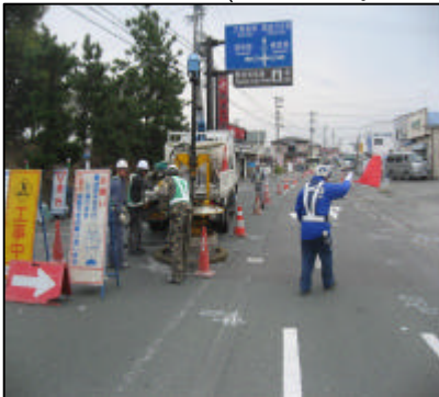
エポ工法(後付工法) 切削前(1次施工)
