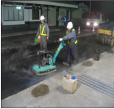
瀝青安定処理 1層目
