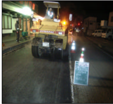
瀝青安定処理 2層目
