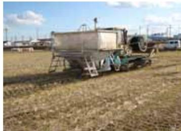
一部完成については、水甲・集水管施工を2班に増やし作業分担を明確にしてドレンレイヤー機械の待ちがないよう施工した。もみ殻の確保は、発注後すぐに地元農協に連絡しもみ殻の搬入があればすぐ連絡をもらうようにした。もみ殻の保管場所については、屋根付きの倉庫を借りる事ができ、農協から連絡が入ればいつでも運搬できる状態にした。雨天時には、もみ殻詰め作業ができたため現場での待ちも無く工期短縮につながった。
