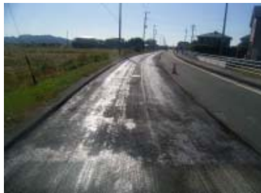
防塵処理乳剤散布完了
