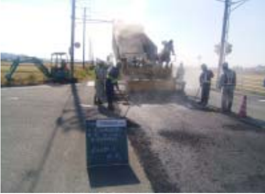
瀝青安定処理工施工状況
