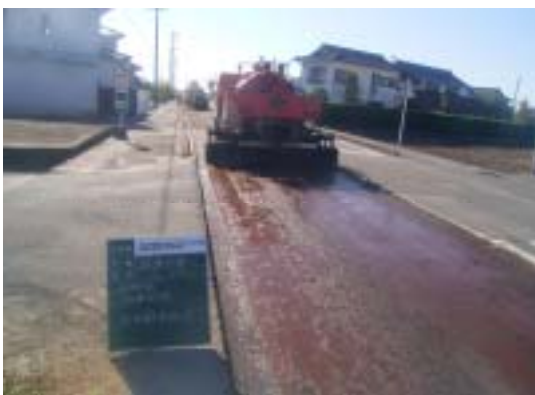
防塵処理乳剤散布状況
