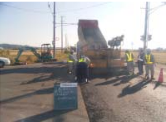
基層工施工状況
