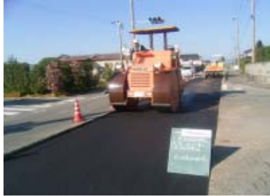
基層工施工状況
