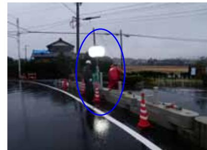
新設道路開通後、当初の区画線工の設計では直線的な道路のため、停止位置で一般車両が止まらない可能性があったため、道路の曲がりをつくって、車が逆に曲がりにくくするようにし停止線の位置を前に出し、見通しのよいものに変更し、停止位置で止まりやすいように設計変更をした。
