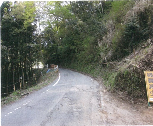
工事着手前 工事起点～工事終点を望む
