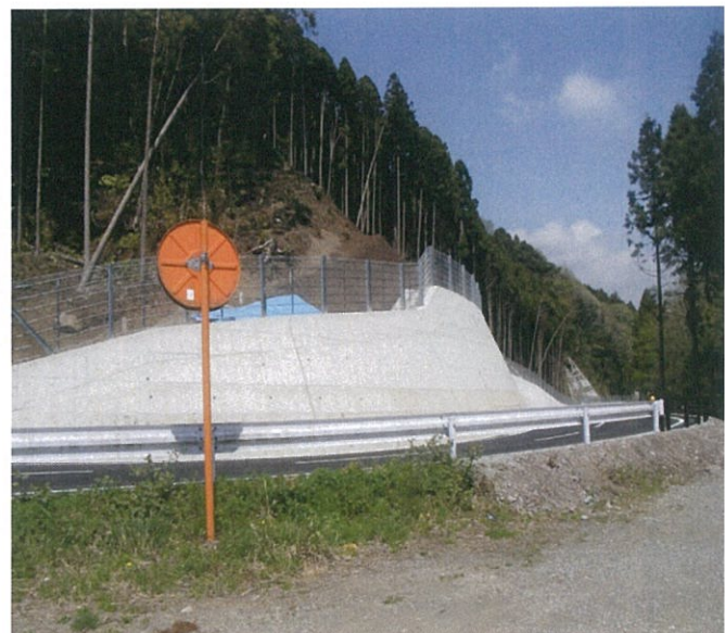
工事完了 工事終点から工事起点を望む
