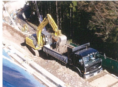
底部の残土搬出は11tダンプにて残土搬出
