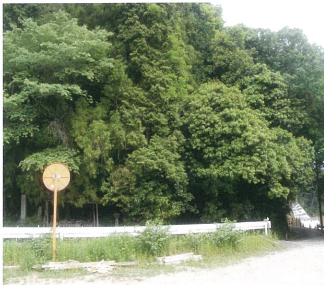
工事着手前 工事終点から工事起点を望む
