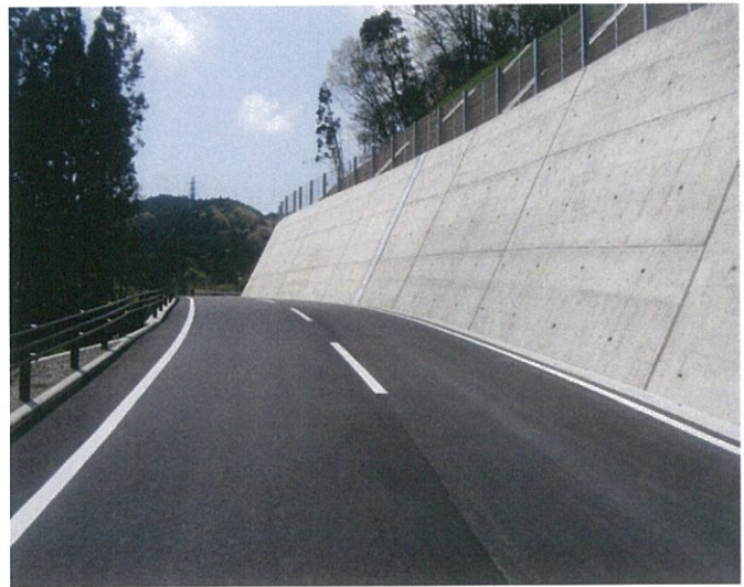
工事完了 工事起点～工事終点を望む
