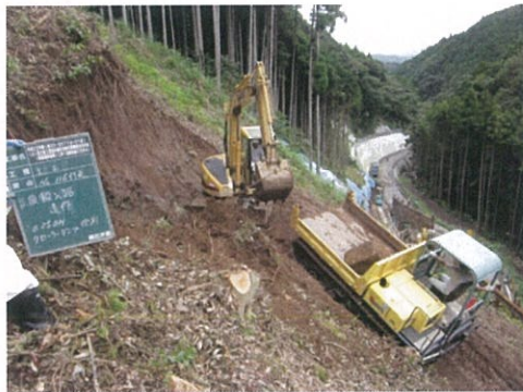
高所部の仮設道路並びに残土搬出はクローラダンプの併用で施工
