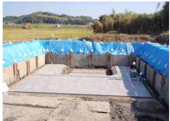
【仮設工設置完了】
