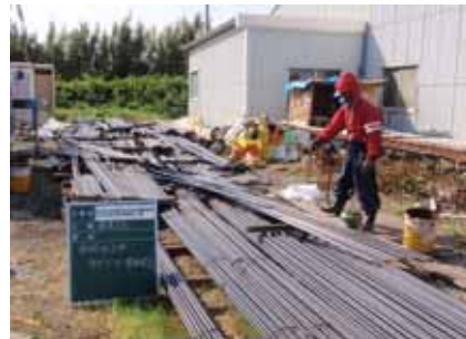
【防錆材塗布作業】
