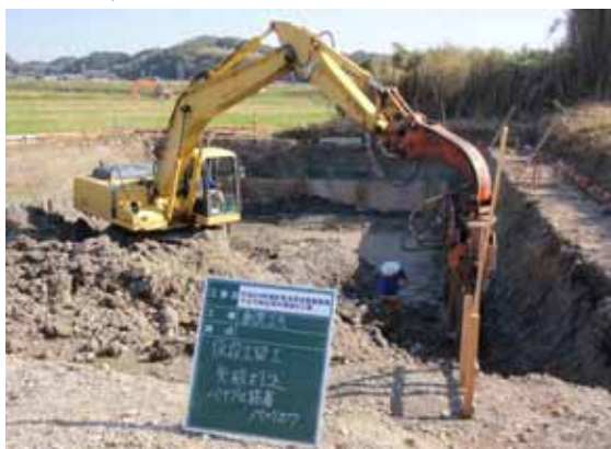
【鋼矢板打設状況】
