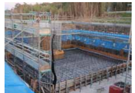
【鉄筋組立完了】
