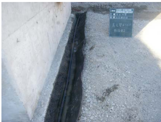
φ50有孔管 設置状況
