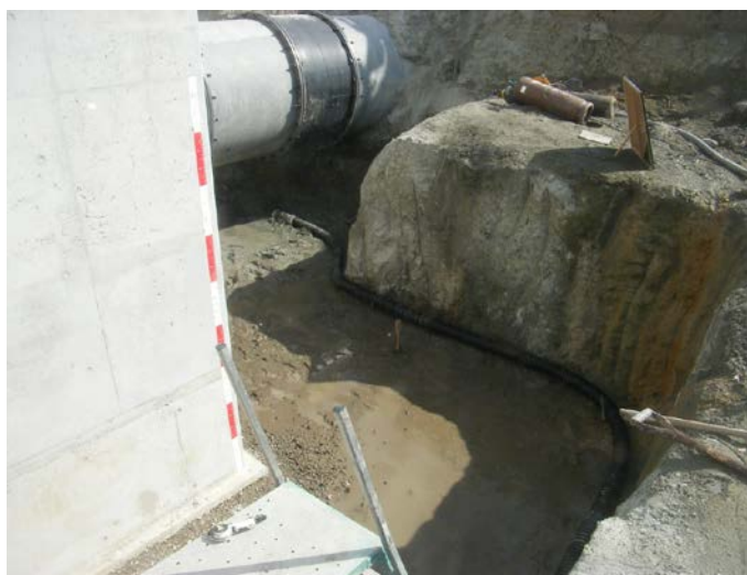
有孔管 設置状況
