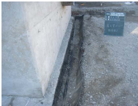
巻き立て砕石状況
