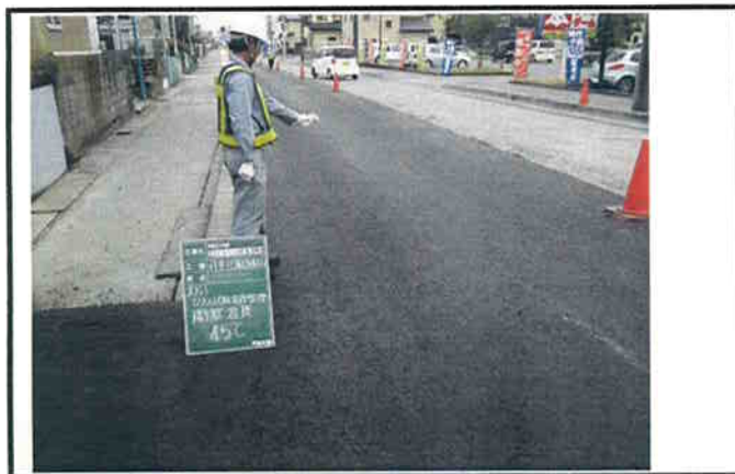
図-3(赤外線センサーによる表面温度測定)
