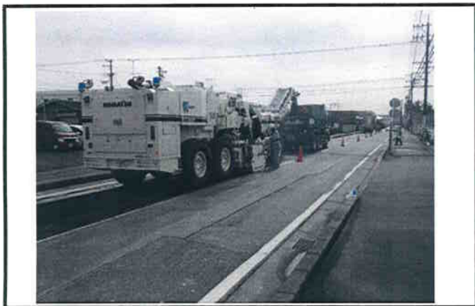
図-1(路面切削状況)
