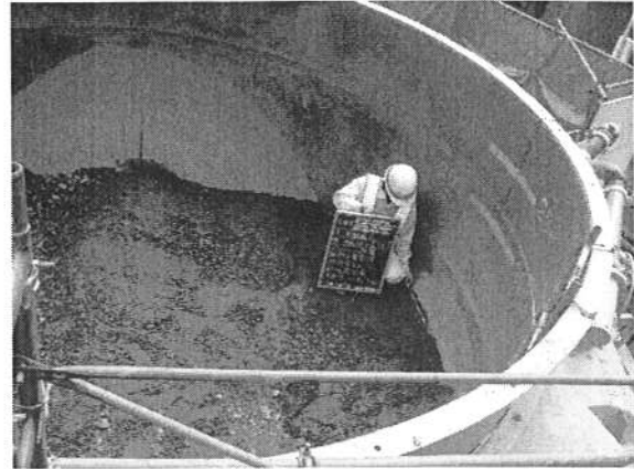
掘削土量確認(推進開始前)
