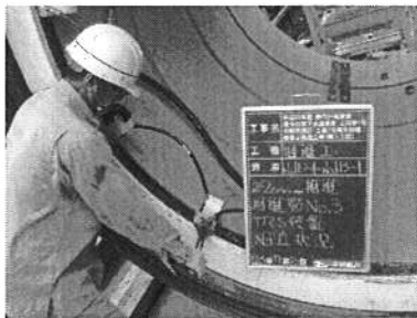
TRS装置 組立・取付状況
