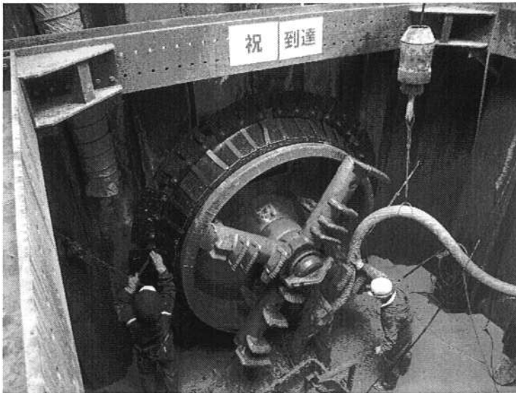
掘進機到達状況
