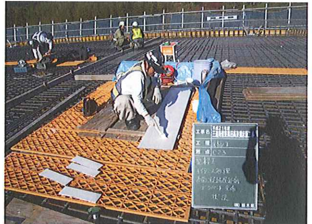
【止め型枠「デラパント」塗布】
