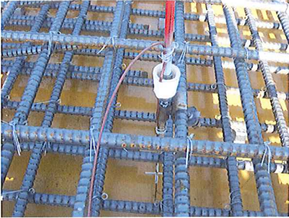
【温度計配線完了】
