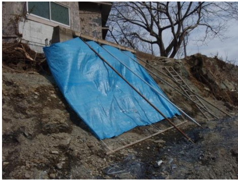
単管パイプと角材、鉄筋による簡易補強
