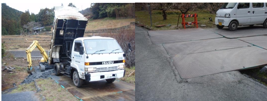
土砂運搬状況
