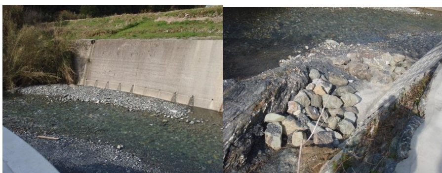
既設ブロックに土砂盛り付け
