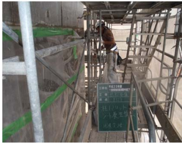
写真-4 ポリエチレンフィルム撤去状況(壁部)
