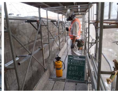
写真-6 養生剤散布状況(梁部)
