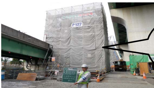
写真-1 コンクリートメッシュシート完了全景
