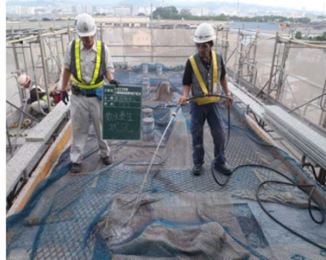
写真-5 散水養生状況(梁天端部)
