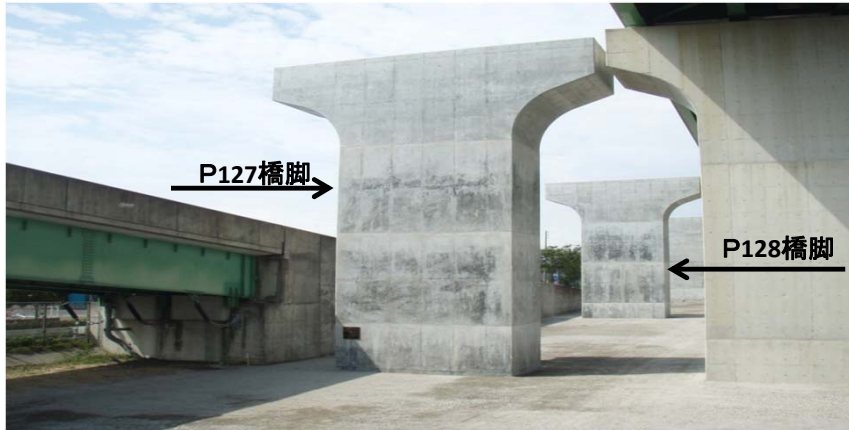
写真-7 完成写真
