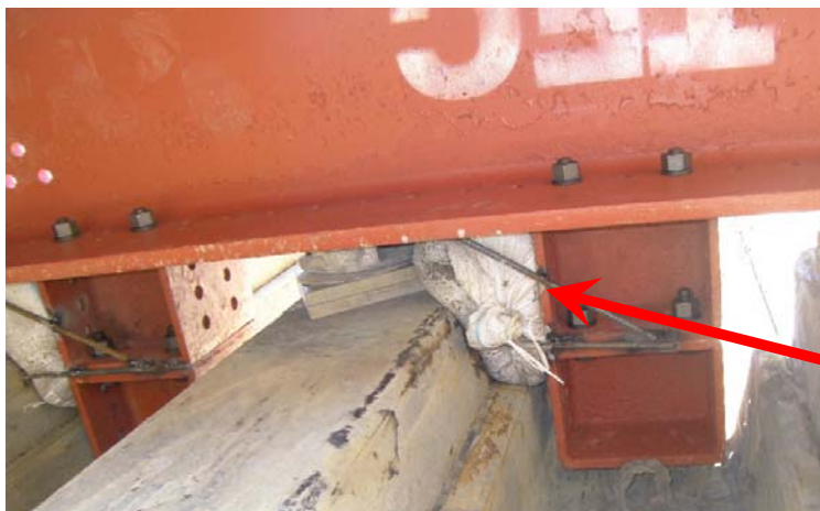
活動防止設置完了 下から見た状況
