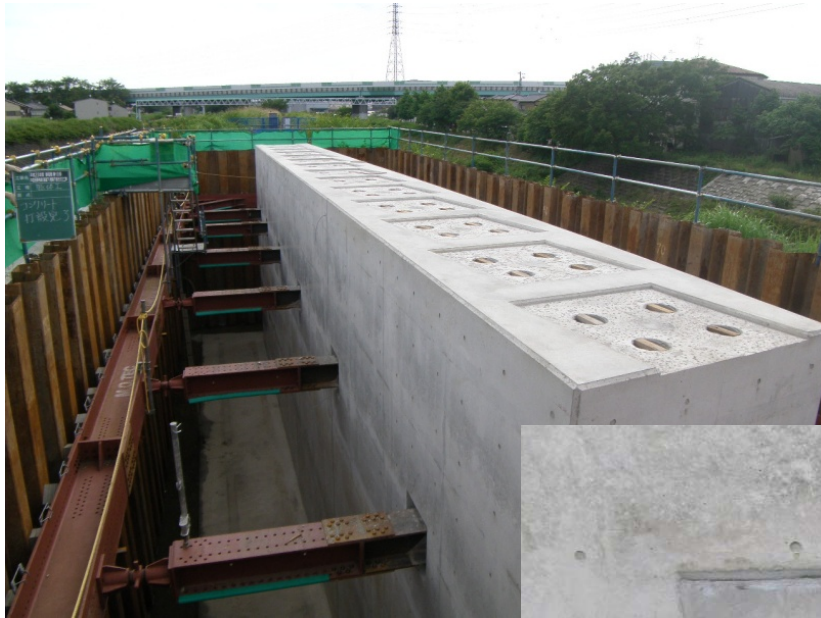
埋戻し前(山留架設状況)
