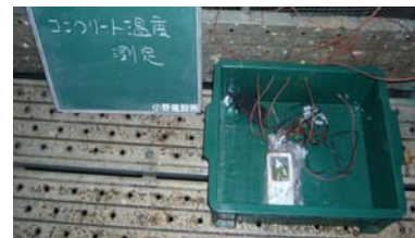
コンクリート内部・表面温度測定状況
