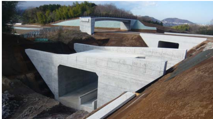
側道ボックス施工完了
