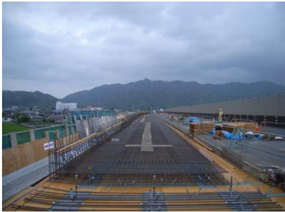
STEP-3 拡幅床版コンクリート打設
