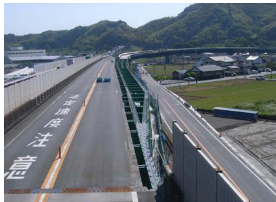
STEP-2 型枠・鉄筋組立
