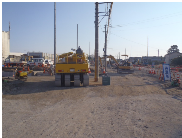
路床盛土施工時における電柱配置状況
