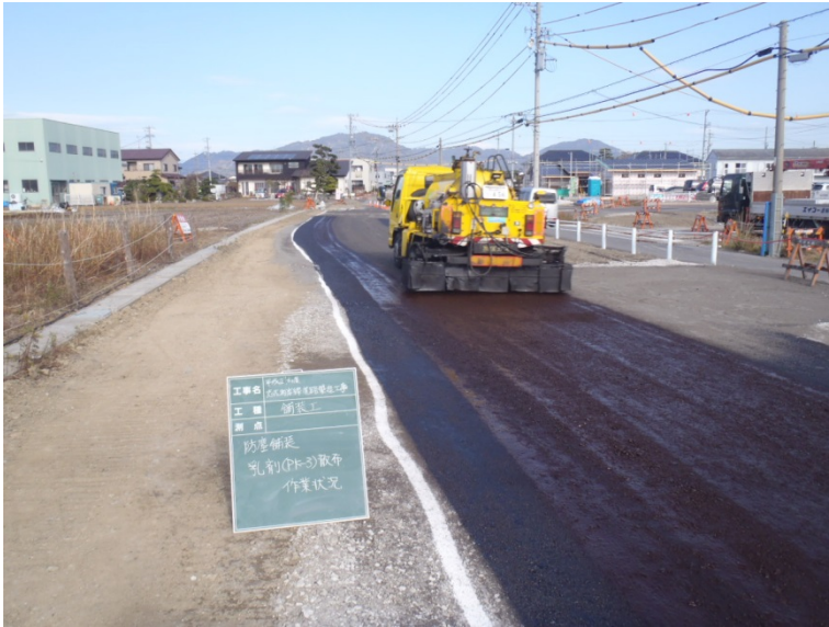
防塵舗装施工状況
