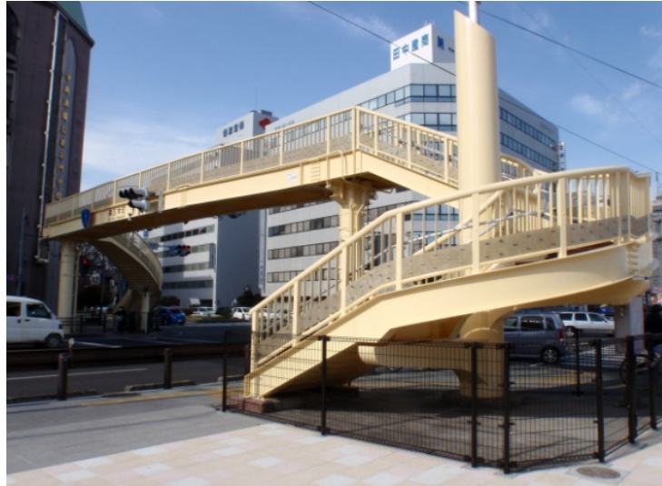
国道1号線 栄町横断歩道橋
