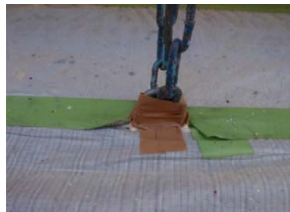
設置箇所拡大写真
