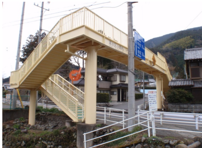
国道52号線 小河内横断歩道橋
