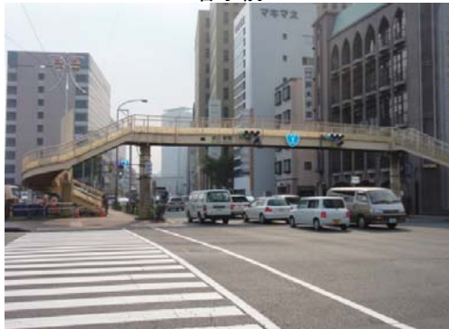
国道1号線 栄町横断歩道橋
