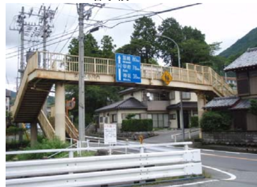
国道52号線 小河内横断歩道橋
