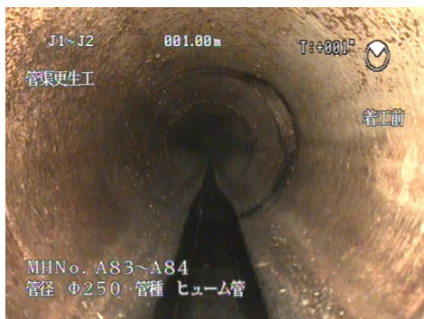
写真3 現場写真(着工前)
