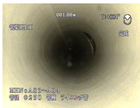
写真4 現場写真(施工後)
