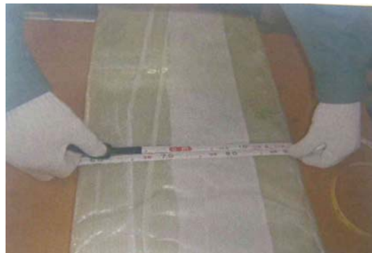
写真2 更生管周長確認
